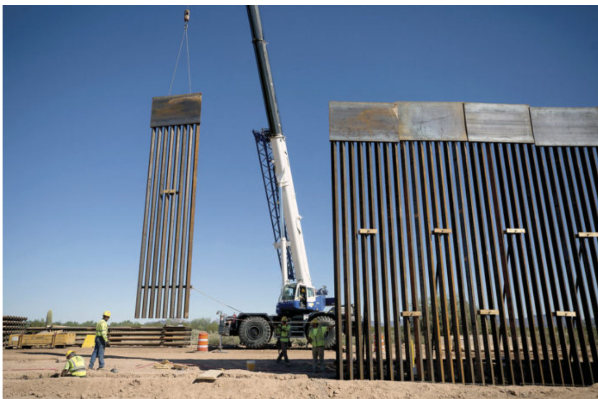
Trabajadores avanzan en la renovación de la barrera en la frontera México-EU, en Arizona, el viernes. Foto: AP
